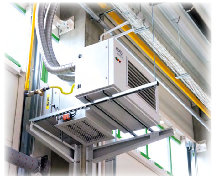
Центробежный (модели Eolo AC) для передачи воздуха по вентканалам
