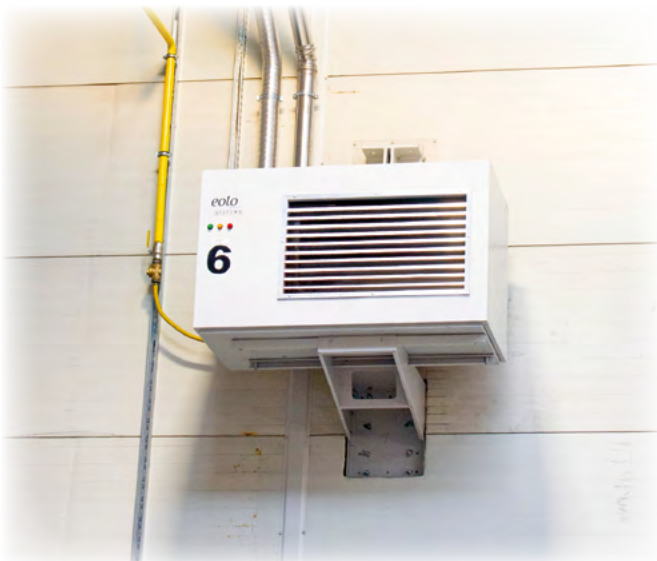
Осевой ( модели Eolo AE) для прямой передачи воздуха
